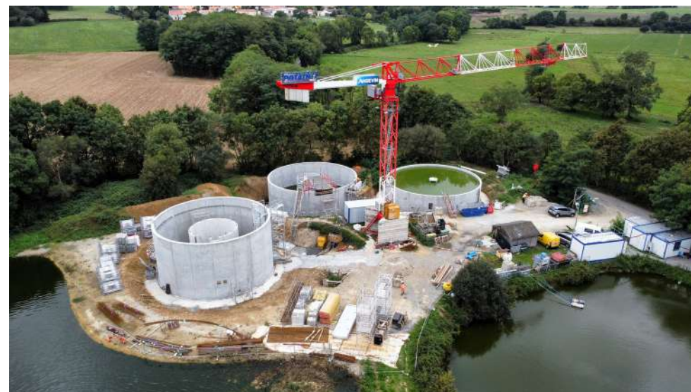
Construction station d'épuration de Brains 16
