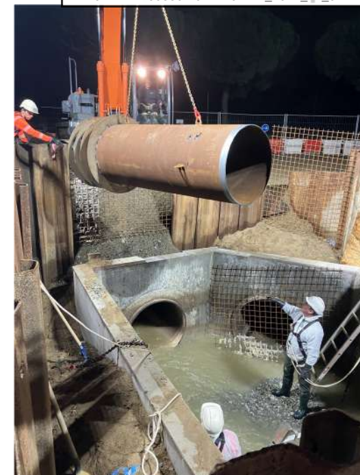
Renouvellement réseaux ZAC Pirmil les Isles
