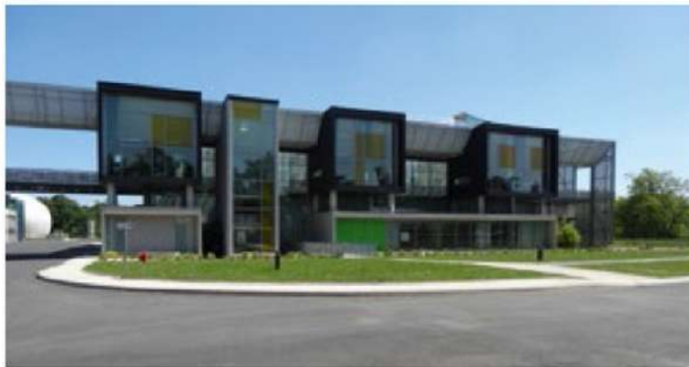
Station d'épuration Petite-Californie
