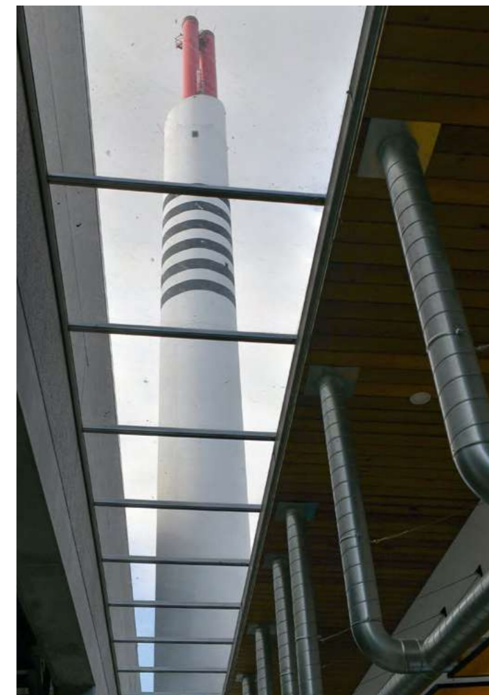
Cheminée de l'usine ARC EN CIEL 2034
