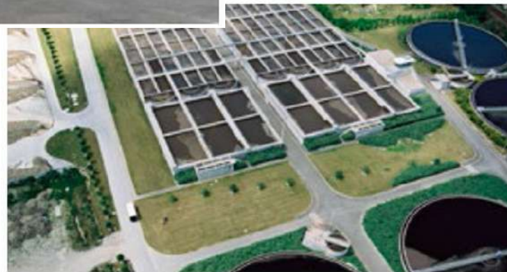
Station d'épuration de Tougas
