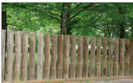
Clôture de bastings de bois traités et dressés
